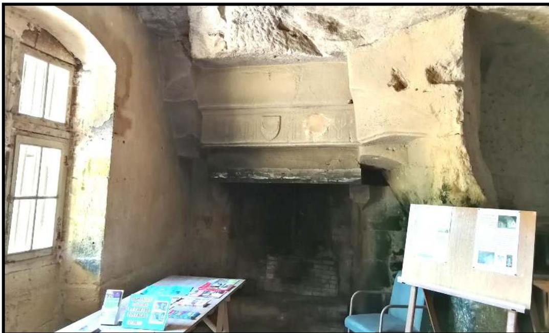
La grande pièce est fermée sur l'extérieur par un mur, constitué en grand appareil sur le bas et en moyen et petit appareil sur le haut, ce qui laisse à penser que le bas a été refait.
