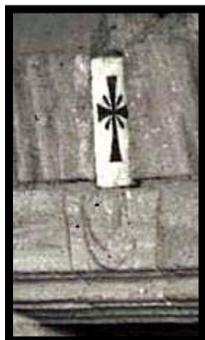
La pierre au-dessus de la clé du linteau est d'un matériau différent des deux autres grosses pierres qui font la jonction avec la roche. Sa forme n'est pas exactement adaptée à l'espace. Est-elle là pour combler une niche ancienne comme il y en a une au même endroit à l'intérieur ?
